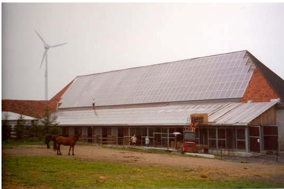
Abb. 23: Darstellung einer Photovoltaikanlage auf einem Reitbetrieb
