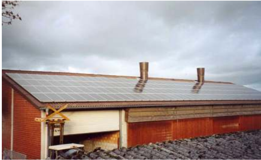
Abb. 34: Gesamtansicht der Photovoltaikanlage Georg Humpert
