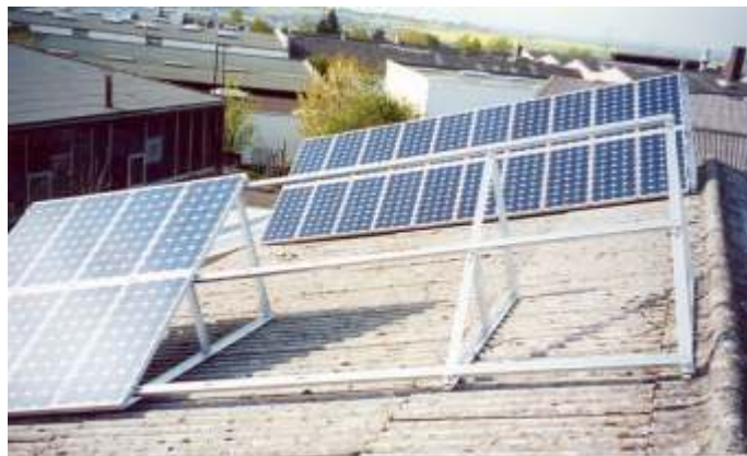
Abb. 16: Prinzip der Aufständering von Photovoltaikmodulen
