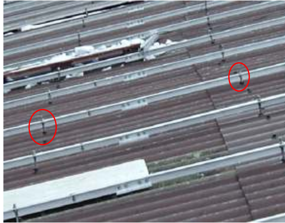
Abb. 27: Verteilung und Installation der Stockschrauben
