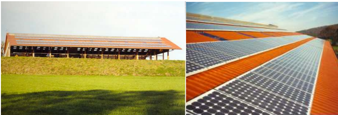
Abb. 26: Ausrichtung der Module auf einem Offenfront-Milchviehstall
