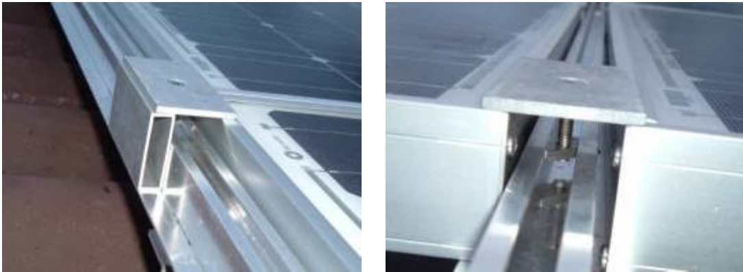
Abb. 30: Prinzip der Modulverbindung und Befestigung
