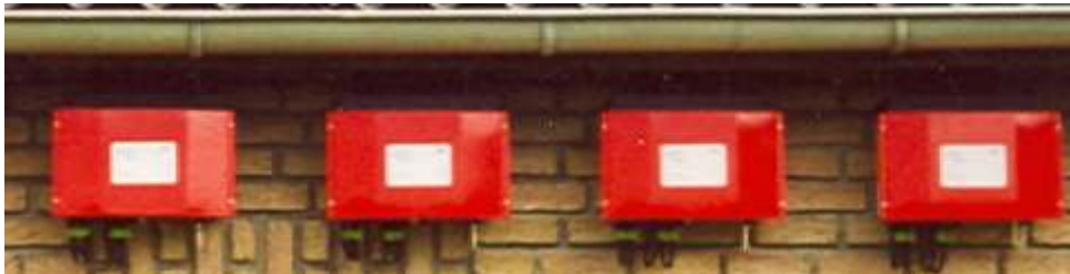
Abb. 32: Befestigung und Platzierung der Wechselrichter
